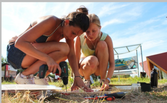
Bau der Duschkabine für die Solardusche
