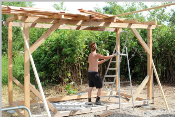
Bau der Duschkabine für die Solardusche
