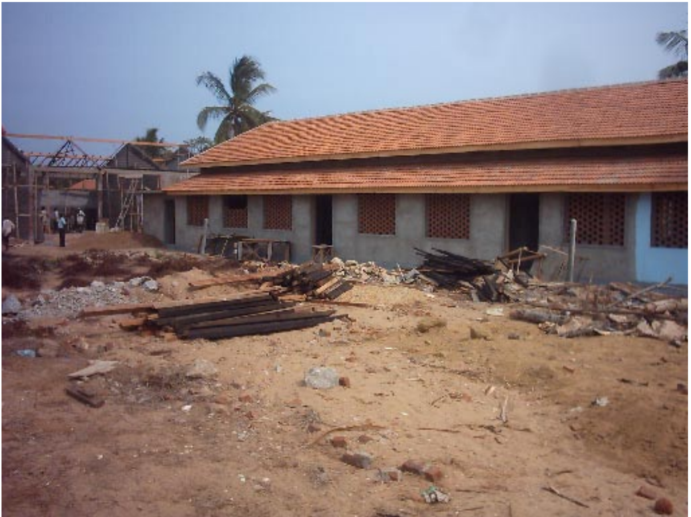
Der Wiederaufbau des zerstörten Berufsausbildungszentrums in Kalmunai geht voran.
